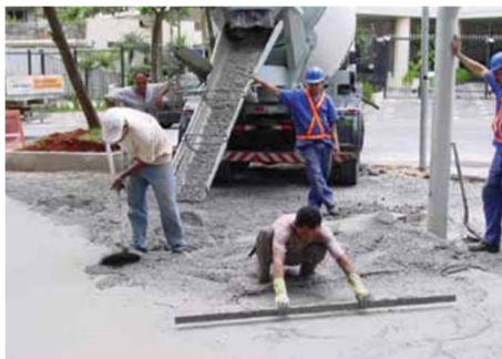
Figura 8 – Recebimento e espalhamento do concreto.
