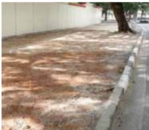
Figura 6 – Nivelamento e compactação do terreno
