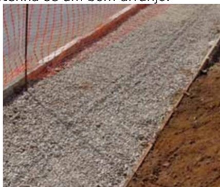
Figura 7 – Espalhamento da camada de Brita
